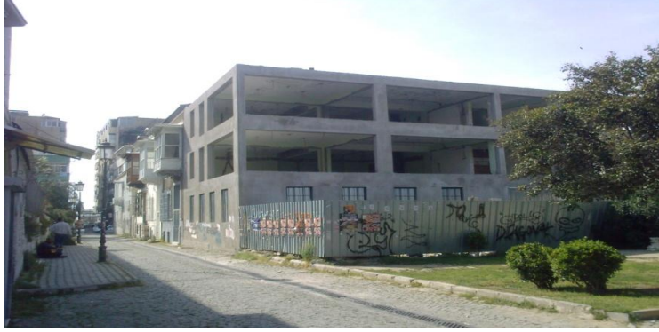
(İzmir ilinde alınan binadan görünüm)
